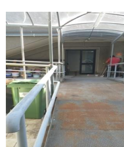
Ingresso Vano scala posteriore C
